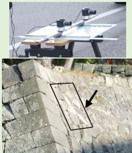
石垣崩落危険部位の簡易光学計測
